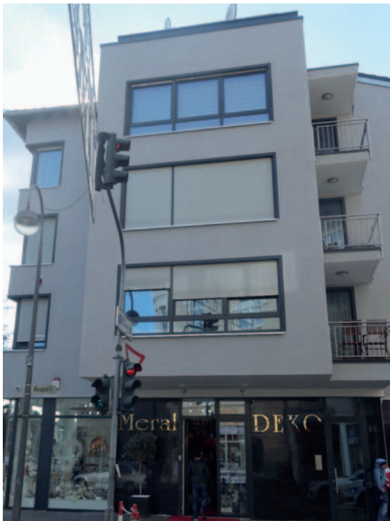
Das neue Geschäft von Meral Sahin, Gladbacher Str. /Ecke Keupstraße
